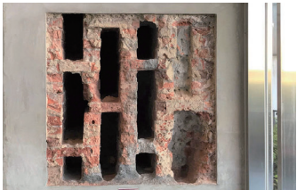
ビール工場として内部の温度を一定に保つための中空構造を持つ5重の複壁。
