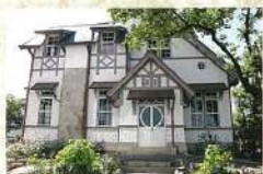
東面から見た建物外観
